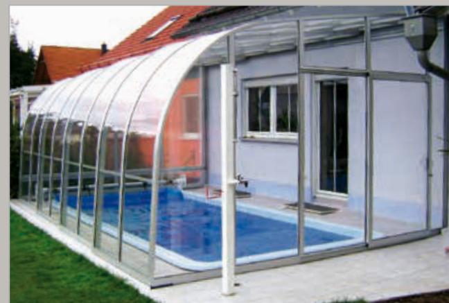
Anbau an einer Hauswand
