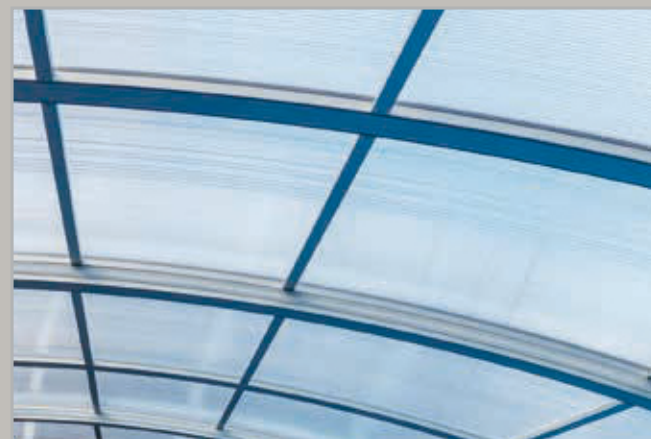
Polycarbonat-Doppelstegplattenverglasung mit verstärktem UV-Schutz bis zu 15 Jahre
