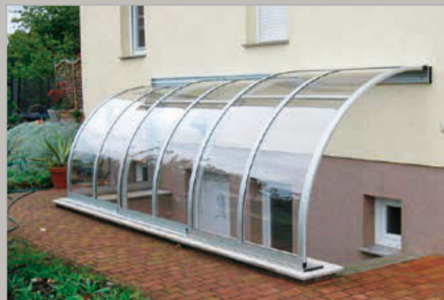
Anbau als überdachter Kellerabgang
